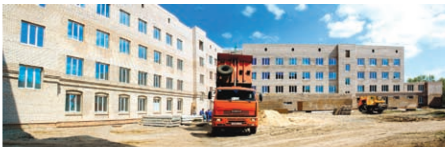
Строительство нового здания районной поликлиники МУЗ «Саракташская ЦРБ»
